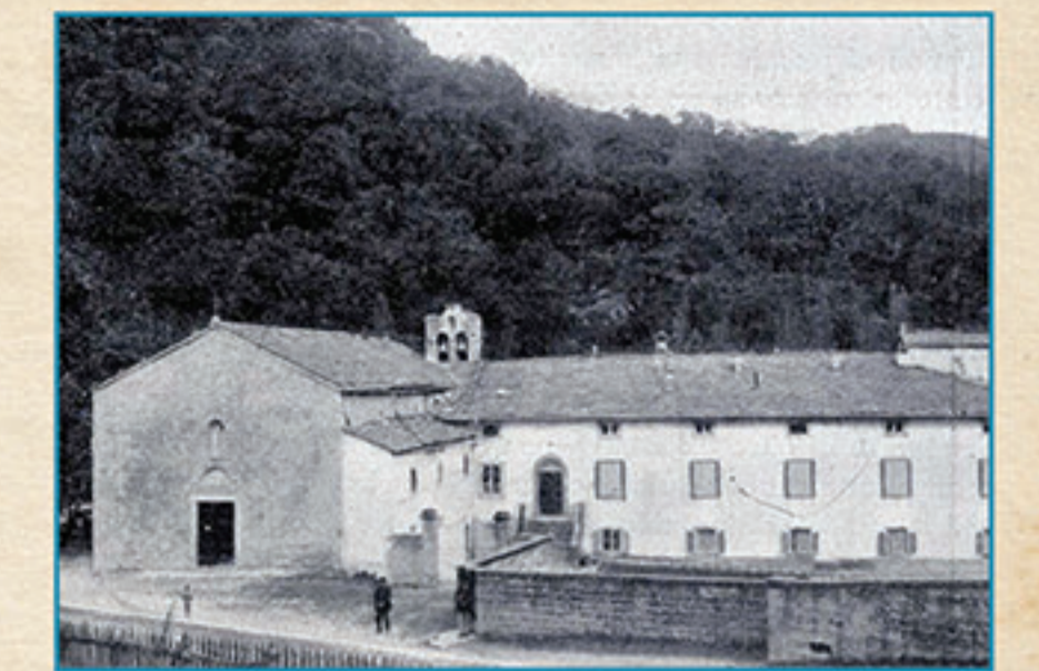
Casa di amministrazione e chiesa di Badia Prataglia (1914).
